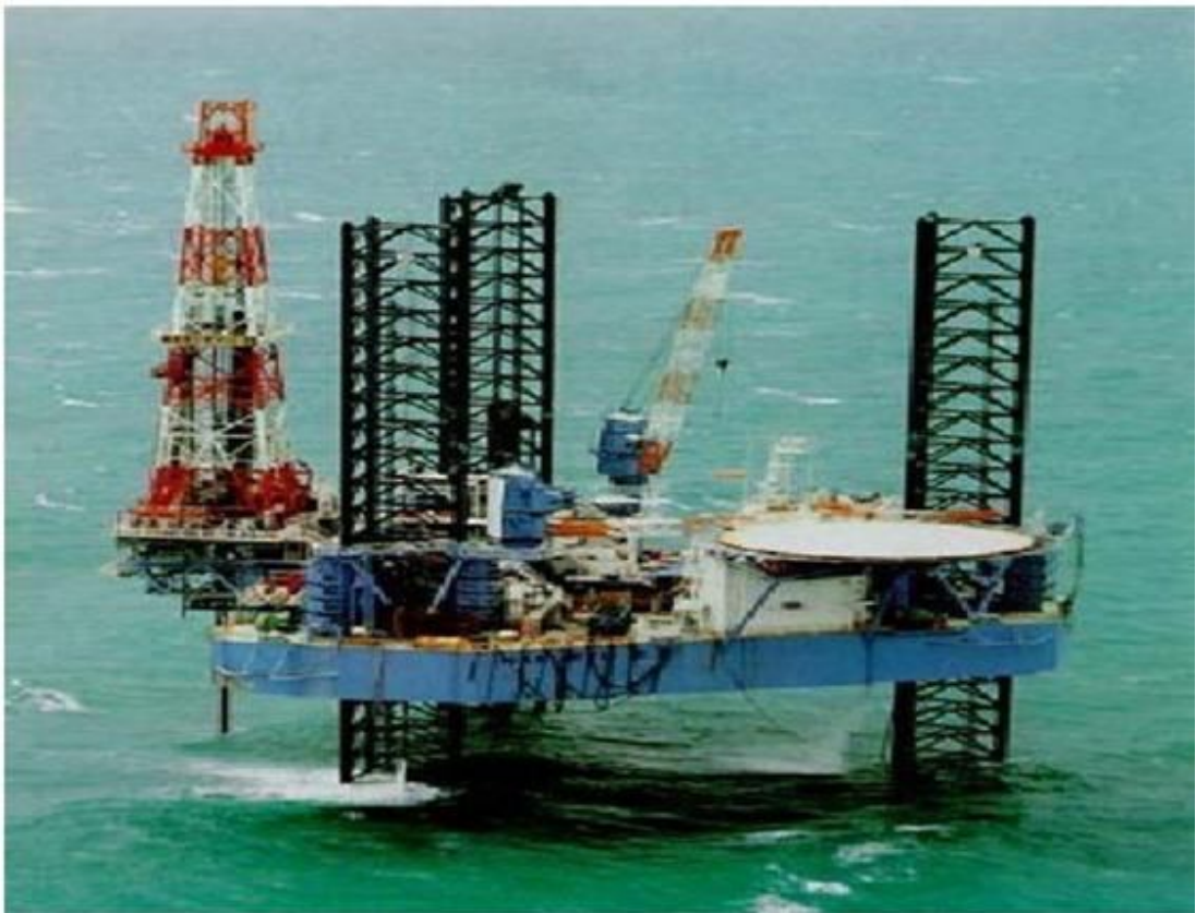
شکل ۱۱-۲- تجهیزات حفاری Jack-up با سه پایه مثالی.
